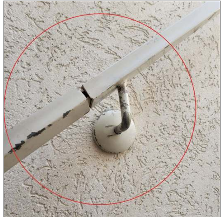
מאחז יד מדרגות יציאה לגג
