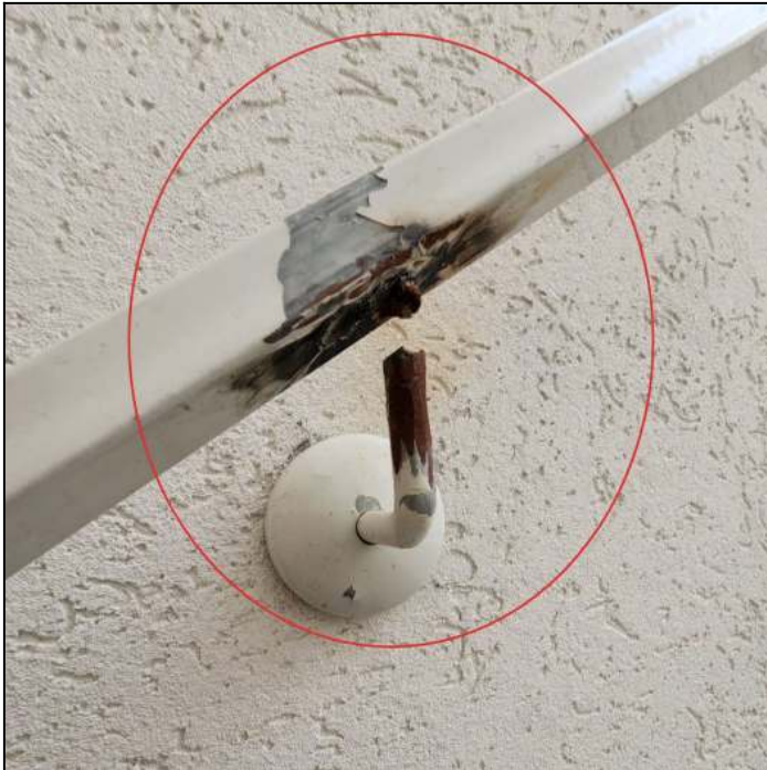
מאחז יד מדרגות יציאה לגג
