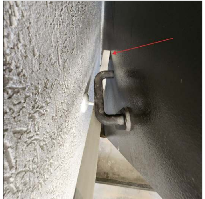
מאחז יד מדרגות יציאה לגג
