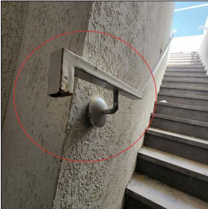
מאחז יד מדרגות יציאה לגג
