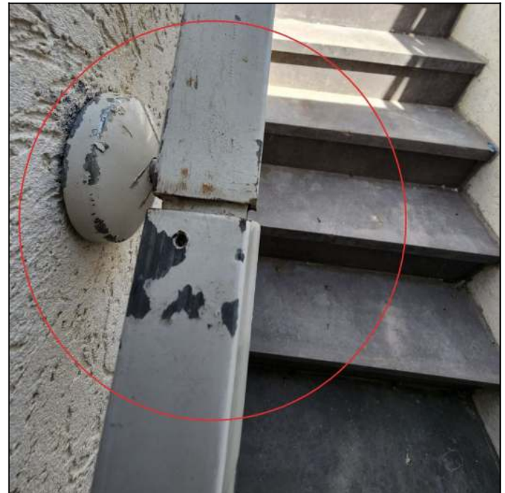
מאחז יד מדרגות יציאה לגג
