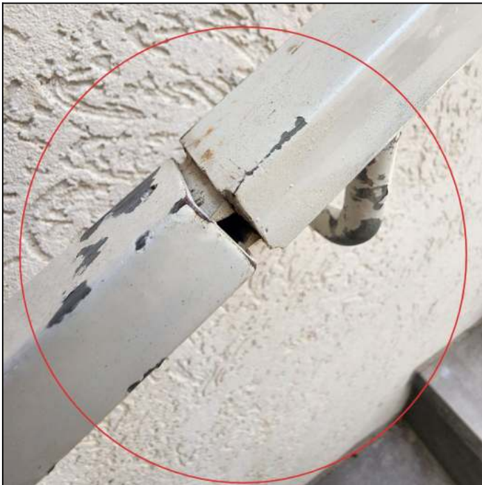
מאחז יד מדרגות יציאה לגג
