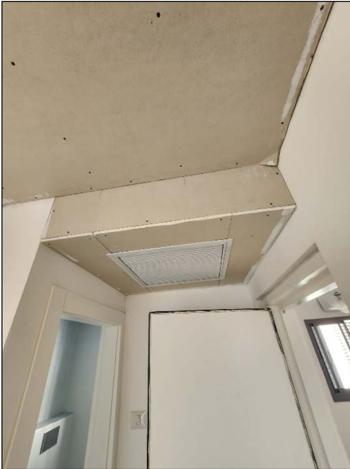
תיקון, שפכטל, שיוף וצבע
