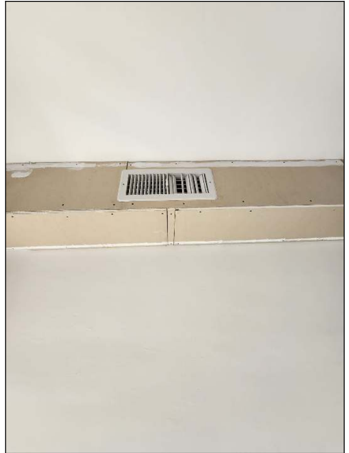
תיקון, שפכטל, שיוף וצבע
