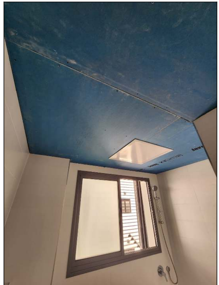
תיקון, שפכטל, שיוף וצבע
