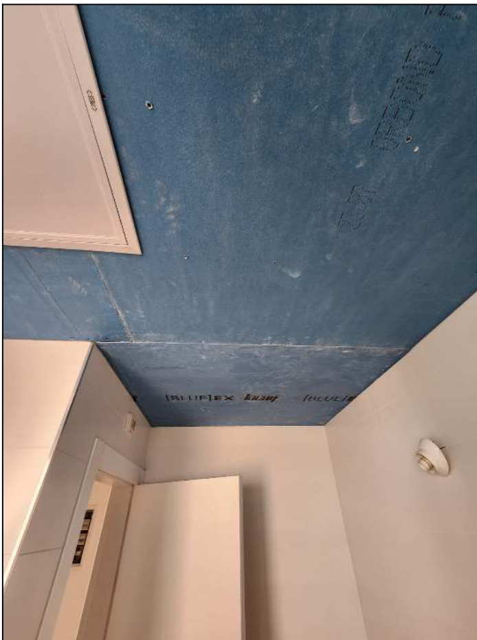
תיקון, שפכטל, שיוף וצבע
