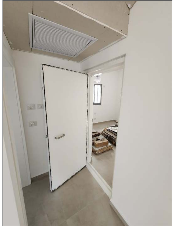
תיקון, שפכטל, שיוף וצבע
