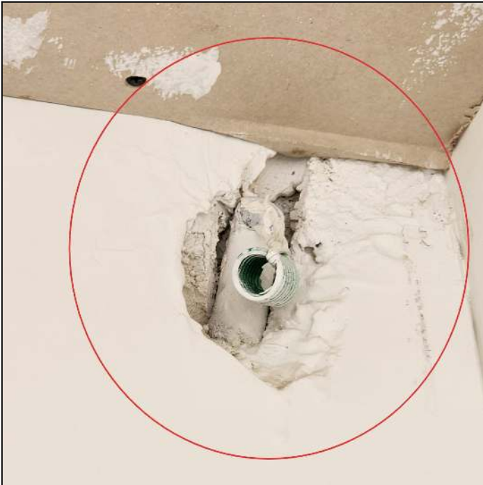
תיקון , שפכטל , שיוף וצבע
