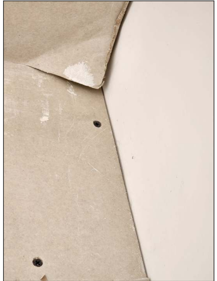
תיקון, שפכטל, שיוף וצבע
