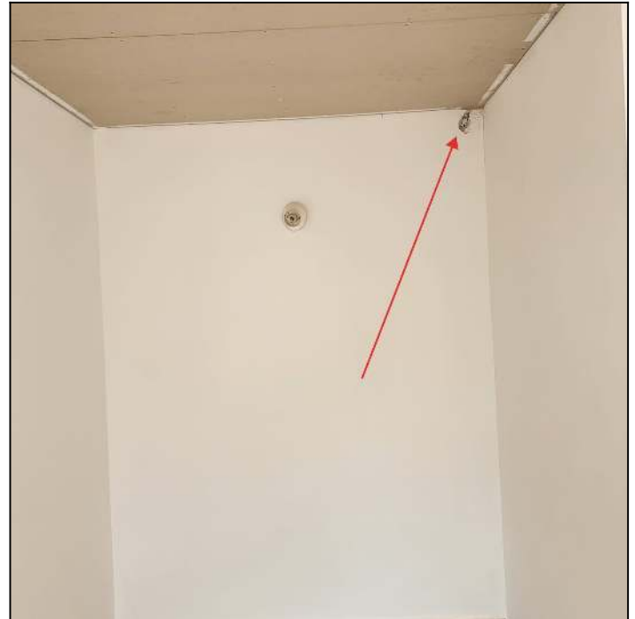
תיקון , שפכטל , שיוף וצבע
