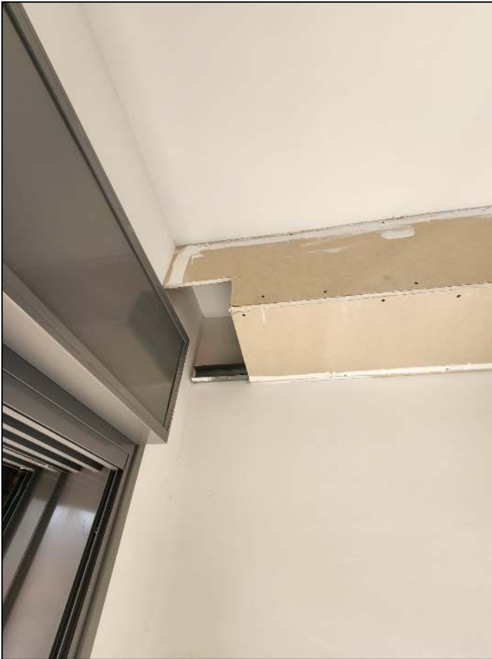
תיקון, שפכטל, שיוף וצבע
