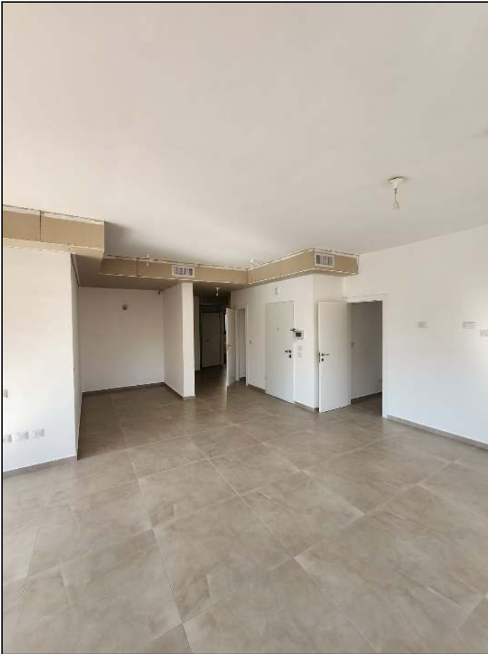
תיקון, שפכטל, שיוף וצבע
